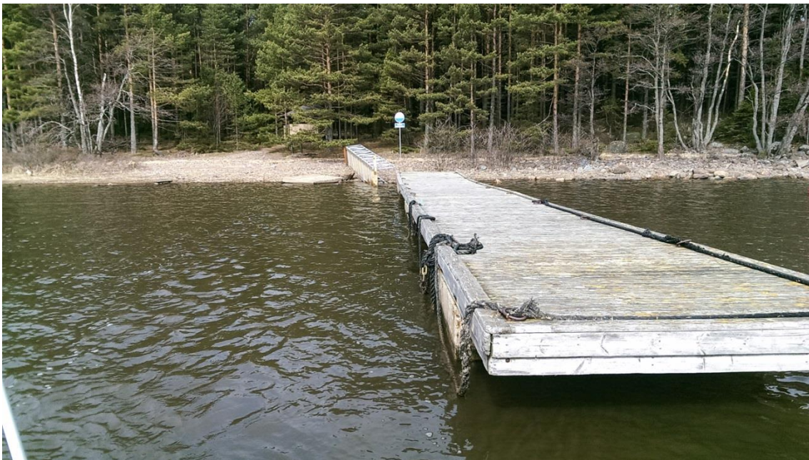
Kuva 1. Seliskerin iso laituri on siirtynyt sijaintipaikaltaan noin 10 metriä.
