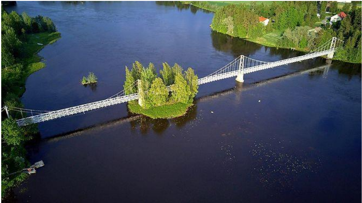
Kuva 31. Peruskorjattu Keikyän riippusilta syksyllä 2020. Silta sijoittuu useilla perusteilla valtakunnallisesti arvokkaaseen joki- ja voimalaitosmaisemaan. Valokuva: Petri Äikiä @jytkypete.
