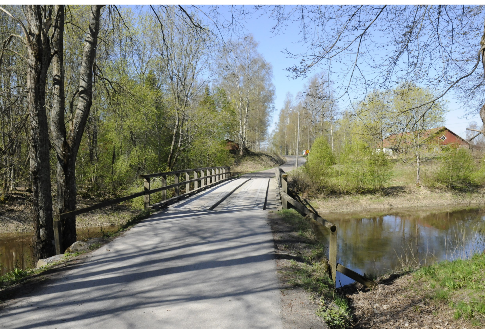
Kuva 28. Ulvilan Kirkkojuovan ylittävä Saaren silta. Valokuva: Kari Mäntylä 2021.
